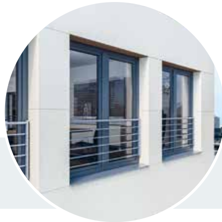
Im Bild: Absturzsicherung mit Glas und Edelstahlstange
