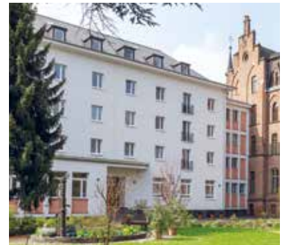
Ausstattung des Neubaus St. Josefstift in Trier: Hier wurden mehr als 170 Fenster produziert und montiert.
