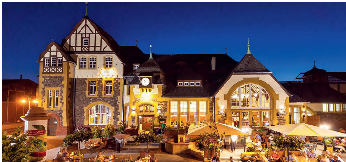
Bahnhof in Bernkastel-Kues – Sämtliche Holzfenster wurden nach Vorgaben der Denkmalpflegebehörde produziert.
